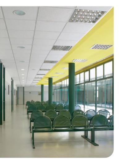
Baldosa Cielovinil Phoenix, con revestimiento de vinyl, por un lado, que brinda una alta reflexión de la luz y es facil de limpiar; y por el reverso posee un revestimiento de foil de aluminio, para proteger de la humedad a la baldosa
